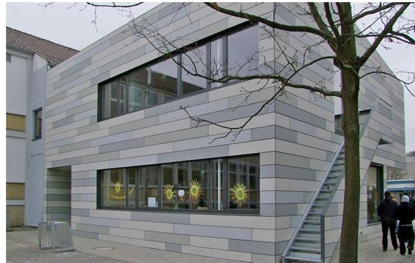
Der Anbau wurde als Holztafelbau mit einer Holzdeckenscheibe und einer Holz-Beton-Verbunddecke mit Scheibenwirkung errichtet. Der zwei Klassenzimmer umfassende Bau krägt im Obergeschoss 3,7m über den unteren Klassenraum hinaus. Die Auskragung wurde auf einer Seite punktuell durch eine Stahlstütze unterstützt. Auf der anderen Seite wurde der Abschlusssträger durch ein Fachwerksystem in der Wandebene abgefangen. Die vertikale Aussteifung erfolgte über beidseitig beplankte Holztafelwände.
