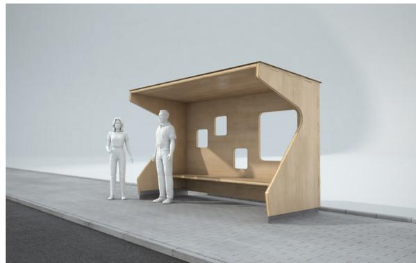
Verschraubung erfolgen konnte. Trotz nur kurzer Nutzungsdauer musste eine Gründung auf Stahlbetonfertigplatten gewählt werden. Die Entwicklung erfolgte für eine Kleinserie von 30 Fahrgastunterständen. 17 wurden realisiert, einige erfuhren Nachnutzungen z.B. als Trainerhäuschen in Sportvereinen.
