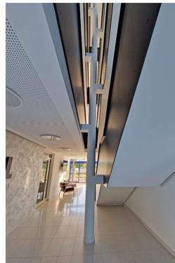
zusätzliche Stahlbetonstütze als Auflager vorgesehen.
