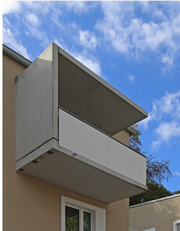
den Stahlbeton- und MW Wänden. Das Gebäude ist flachgegründet. Die Sohlplatte ist eine elastisch gebettete Stahlbetonplatte. Die Balkone bestehen aus FT-Platten und FT-Wandscheiben.
