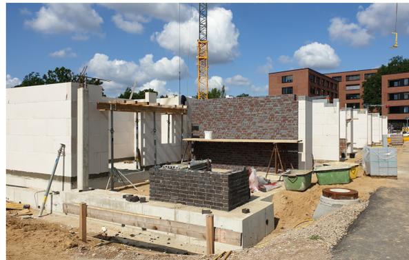
Träger vorgesehen. Über den in der Fassade teilweise versetzt angeordneten Fensteröffnungen werden Stahlbetonunterzüge mit einer Mindesthöhe von 40cm geplant. Über dem Stellplatz im EG fängt ein Unterzug  $b/h=24/40$  die Fassadenlasten ab. Die flankierenden Wände des Stellplatzes werden in Klinkermauerwerk ausgeführt und über einen Kimmstein von der EG-Decke thermisch getrennt.
