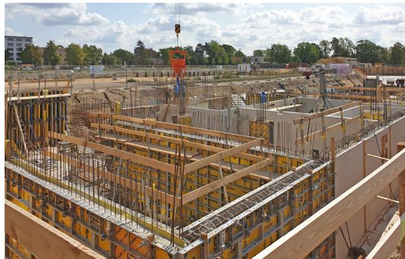
herangezogen. Im Bereich der Gebäudefugen werden die Wohnungstrennwände als Doppelwände mit jeweils  $d=15\text{cm}$  ausgebildet. In Teilbereichen müssen die Wohnungstrennwände ebenso wie die hofseitigen Außenwände über der Tiefgarage abgefangen werden. Hierzu werden die Wände als wandartige Träger in Stahlbeton ausgeführt. Die Tiefgarage wird als weiße Wanne in WU-Beton mit einer im überschütteten Bereich  $35\text{cm}$  starken Decke ausgeführt.
