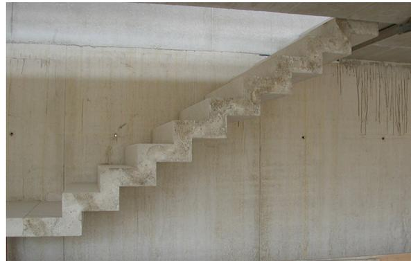
Sie bilden das Installationsgeschoss, in dem die technischen Versorgungsanlagen der darunter liegenden Reinraumnutzung untergebracht sind. Die Mantelbauten sind in Stahlbetonbauweise mit unterzugsfreien Flachdecken ausgeführt und werden zur Aussteifung der Stahlkonstruktion mit genutzt. Die kaskadenartige Treppenanlage wurde aus filigranen Stahlbetonfertigteilen realisiert, die jeweils an den Haupt- sowie durch die Zwischenpodeste gestützt werden.
