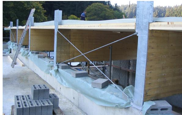
Die Hallendächer sind eine Holzleimbinderkonstruktion mit Dickholzbeplankung und Holz-Pfosten-Riegel-Fassade. Die eingeschossigen Zwischenbauwerke sind Massivkonstruktionen mit Stahlbetondecken und Betonstein-Sichtmauerwerk. Die Gebäudeaussteifung erfolgt durch Mauerwerkskerne. Das Gebäude besitzt eine Flachgründung auf elastisch gebetteter Sohlplatte. Die Hangabfangung wird durch Stahlbetonrahmen realisiert.
