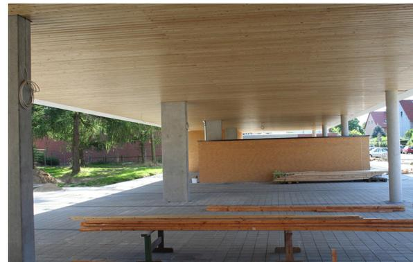
Die Schulerweiterung ist eine Massivkonstruktion in Stahlbetonskelettbauweise mit Haupt- und Nebenträgern, sowie einachsig gespannten Stahlbetondecken. Die Gebäudeaussteifung des durch Fugen in Abschnitte aufgeteilten Bauwerks wird durch Treppenhauskerne und Stahlbetonwände sichergestellt.
