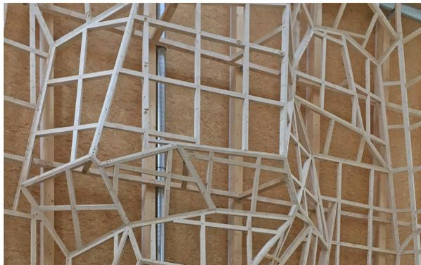
Aussteifung erfolgt im dreigeschossigen Teil mit Wandscheiben, die horizontalen Lasten der Halle werden über Diagonalverbände abgetragen.
