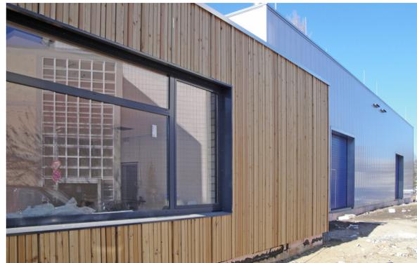
Massivbauweise errichtet. Die Aussteifung erfolgt durch eine Scheibenausbildung der Trapezbleche in Verbindung mit Mauerwerkswänden. Die Gründung ist eine Flachgründung auf elastisch gebetteten Streifenfundamenten. Im Bereich des Schulungstraktes erfolgt die Gründung auf einer elastisch gebetteten Sohlplatte mit Frostschräge. Die Stahlpergola ist eine Stahlrahmenkonstruktion auf Streifen- und Einzelfundamenten.
