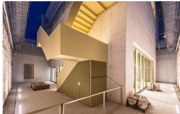
Durch die außenliegenden einschaligen Stahlbetonwandscheiben ergeben sich sehr viele Durchstoßpunkte durch die Wärmedämmung. Um diese Wärmebrücken zu minimieren und um Zwang aus thermischer Beanspruchung zu vermeiden, werden die Decken und Wände thermisch getrennt konstruiert. Die Gebäudeaussteifung erfolgt über die Stahlbetonwandscheiben.
