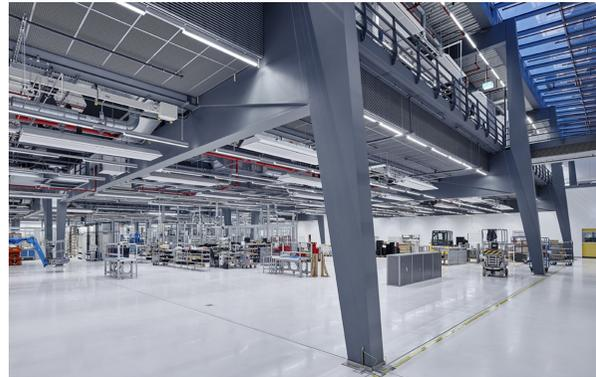
damit für die Stützen eine veränderliche polygonale Querschnittsform, die – Dank der präzisen Ausführung – ein filigranes Lichtspiel erzeugt.
