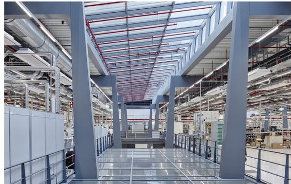
Das Gebäude gliedert sich in eine zweigeschossige Produktionshalle in Stahlverbundbauart mit flankierenden Stahlbetonseitenschiffen für Büros. Über ein gläsernes Atrium mit dem Haupteingang schließt sich ein zweigeschossiger Stahlbetonbau für Produktentwicklung und Labore an.
