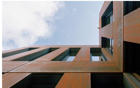
der über zwei Geschosse durchlaufenden Eingangsfassade wurden Fertigteile eingesetzt. Die Decke über dem Saal wird durch eine Wandscheibe im ersten OG abgefangen. Bei der Fassade handelt es sich um eine Konstruktion aus gekanteten Cor-Ten-Stahlelementen.
