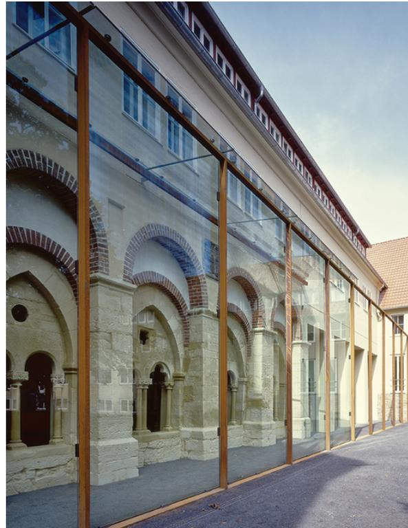
Stiele der Stahlkonstruktion an. Sie ist am unteren Rand für Eigenlast statisch bestimmt gelagert, die Windlasten werden über Randklemmhalter in die Stahlkonstruktion eingeleitet. Die Vertikalverglasung übernimmt keine stützende oder stabilisierende Funktion für die übrige Konstruktion. Die Gründung erfolgt über ein durchgehendes Streifenfundament.
