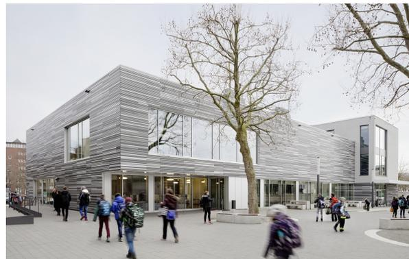
Der dreigeschossige Baukörper wird fugenlos in Stahlbetonbauweise erstellt. Die Wände des Obergeschosses werden als wandartige Träger zum Lastabtrag der 1.OG-Decke und EG-Decke herangezogen. Die Aussteifung der Wandscheiben erfolgt jeweils über Eck durch Querwände bzw. durch die außen umlaufenden Brüstungsträger.
